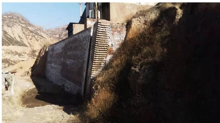
照片8-1 工业场地内边坡
