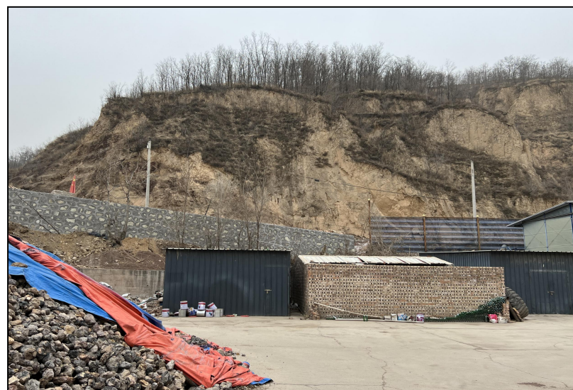
厂区东侧--山体
