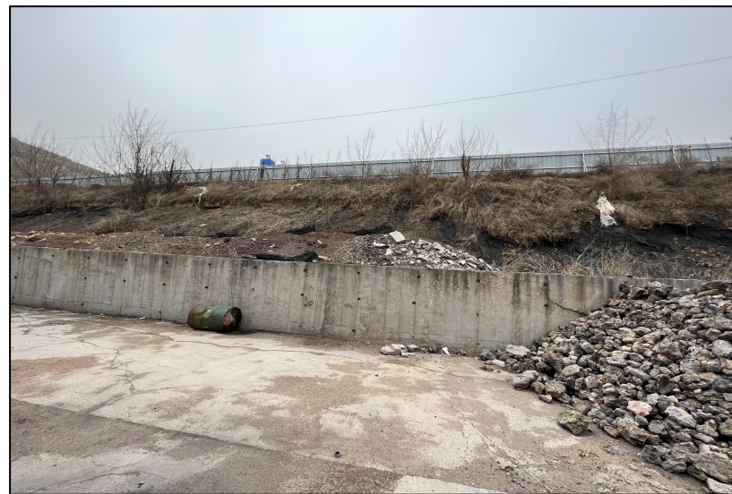
厂区南侧--搅拌站
