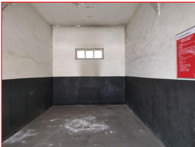
1#危废暂存间内部现状
