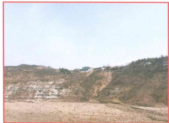
建设场地北侧视图
